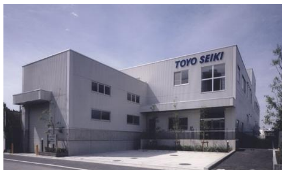
舟渡技术支持中心(东京都板桥区舟渡)
